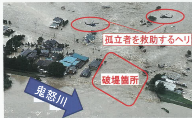
茨城県常総市 鬼怒川破堤 (写真: 国土交通省)
