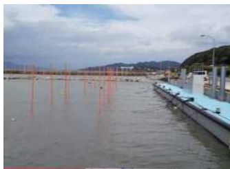
写真① 台風接近時の赤瀬漁港の様子
