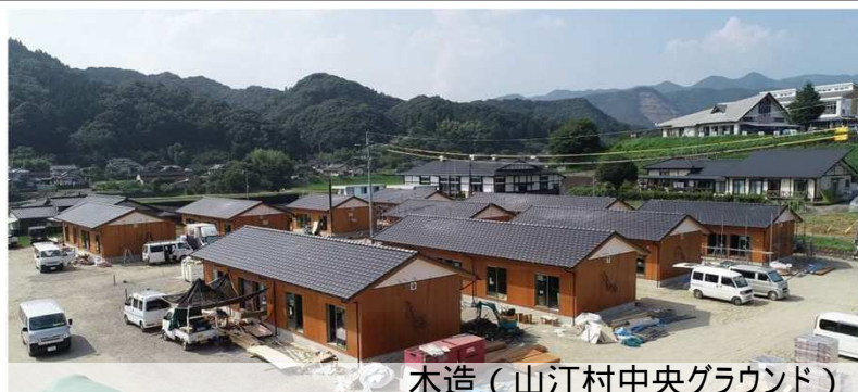
現場状況写真
