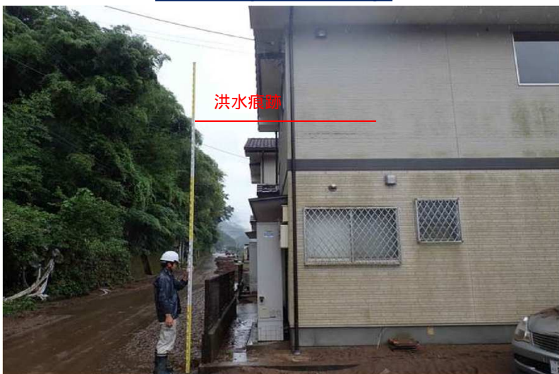
過去に宅地かさ上げした家屋が4m程度浸水 出典: 国土交通省九州地方整備局八代河川国道事務所HP
