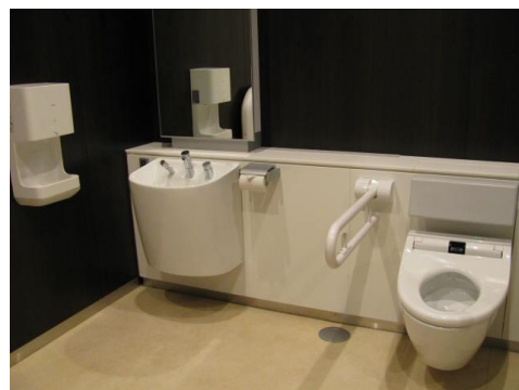
車いす・オストメイト対応トイレ (右) 車いす対応 (左) オストメイト対応
