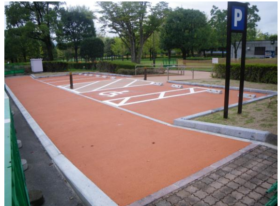
ユニバーサルデザインに基づく駐車場整備 (熊本県テクノ中央緑地)
