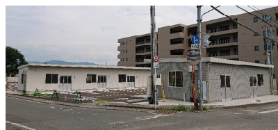
仮設店舗の完成写真
