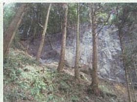
工事名:宇城管内治山事業予防山火山地域第4号工事 企業名:株式会社ニシエ 現場代理人主任技術者:坂田俊作 優れた点:自穿孔式アンカー全孔の定着長事前調査、アンカー前立試験の実施や急傾斜での雷サリ作業箇所での吊り足場設置など品質管理や安全対策に工夫が見られました。
