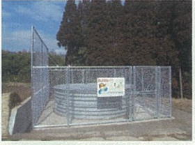
工事名:原原社会資本整備総合交付金(地すべり)工事 企業名:株式会社厚後建設 現場代理人主任技術者:藤原一博 優れた点:工程管理や安全対策に徹底して取り組むとともに、汚濁水の排水について、沈殿タンクを用いるなどの汚濁防止対策に取り組んだ。
