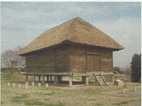
工事名:歴史公園勤王城板倉屋根改修その他工事 企業名:株式会社高田産業 現場代理人主任技術者:高谷 真 主任技術者:吉崎一博 優れた点:茅葺屋根補修というあまり前例の無い特殊な工事でしたが、県内外の茅葺き職人と連携するとともに、地元産の茅を使用した。
