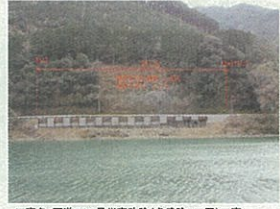
工事名:国道219号災害防除(多武輪2工区)工事 企業名:丸沼建設株式会社 現場代理人及び主任技術者:(本人申出により非公開) 優れた点:作業ヤードが狭間で、交通量も多い箇所であったが、自主的に作業時間外の運動時間帯にも交通指導員を配置するなど交通事故防止に努めた。
