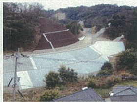
工事名:大矢野北部2期地区農産物集積事業第17号工事 企業名:株式会社藤藤建設 現場代理人主任技術者:野添浩希 優れた点:工事に関する独自の広報誌を作成し、毎月地元住民へ配布するなど、積極的な地元調整が図られました。
