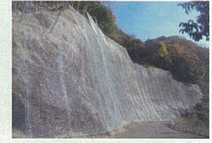
工事名:天瀬阿蘇線活力創出基盤交付金(災害防除)工事 企業名:株式会社ツツヤ工業 現場代理人主任技術者:吉川光寿 優れた点:長期間の工期を予定していたが、全通行車両へのチラシ配布などの安全対策に取り組むとともに、荒後のパトロール・橋本整備など地域貢献に取り組んだ。
