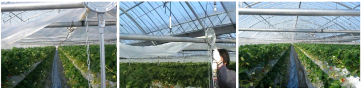
写真1 フィルムを覆った状態 写真2 フィルム巻き取り中 写真3 フィルムを巻き取った状態
