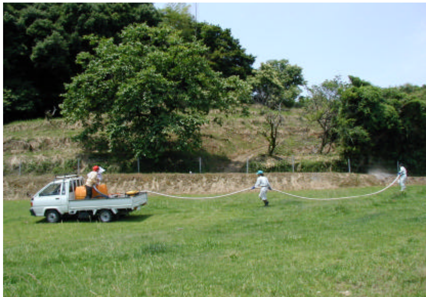
写真1 草地法面への吹付け作業
