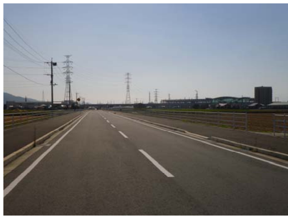
新八代停車場線(八代市西片町)
