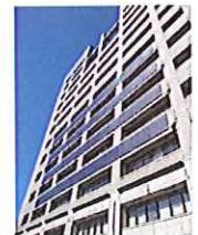
壁面取付け (熊本大学)
