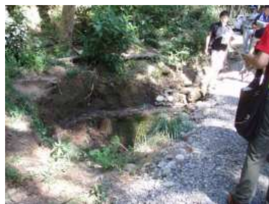
屋根型の路面（手前左から長崎県宇土専門幹・中俣技師） 素掘りの側溝と集水樹（水流を制御する工夫）
