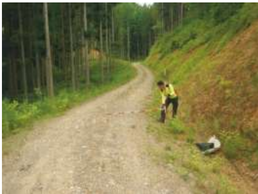
屋根型の形状の路面（岐阜県で現地情報収集の写真）
