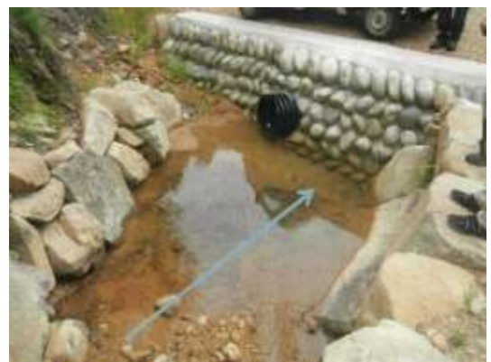
谷部横断暗渠（岐阜県で現地情報収集の写真）
