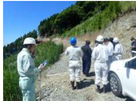
作業道開設状況
