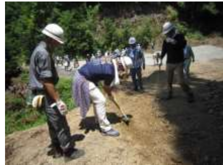
路面整理状況
