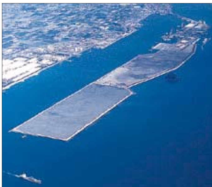
八代港 加賀島地区 土砂処分場
