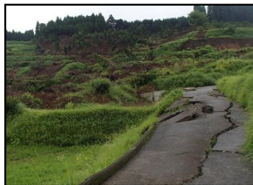
写真② 道路の状況
