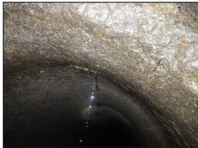
写真② 送水管の状況
