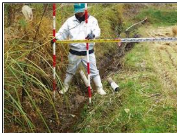
写真② 水路の状況
