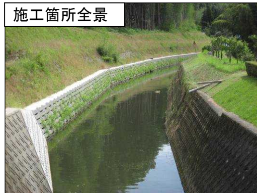
魚巣ブロック (工事施工中の写真)
