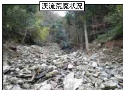
溪流荒廃状況
