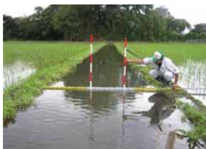
写真 用排分離されていない水路
