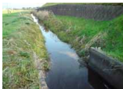
写真 土水路のままの幹線水路
