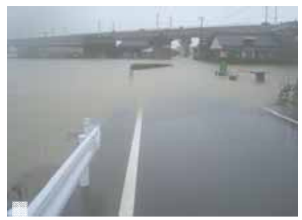
ハウスだけでなく地区の道路も冠水し、道路と水路の区別がつかず危険な状況である
