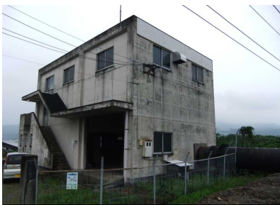
写真① 排水機場の全景
