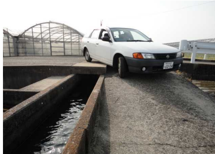
道路幅員が狭く、農産物搬出車両が入りにくい状況である
