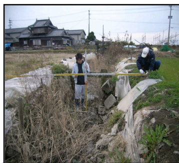
写真② 水路の状況
