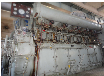
ポンプ設置から30年が経過し、施設の維持管理に苦慮している状況
