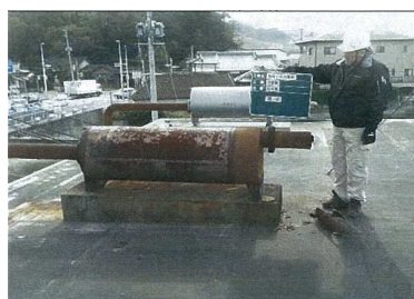
写真② 排水機場施設状況
