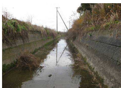
写真② 幹線水路の状況
