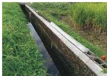
写真② 水路の状況
