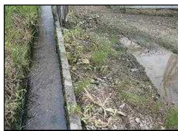
写真② 水路の状況
