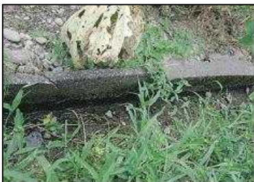
写真① 道路及び水路の状況
