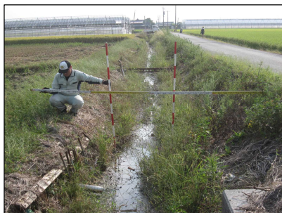
写真② 排水路の状況
