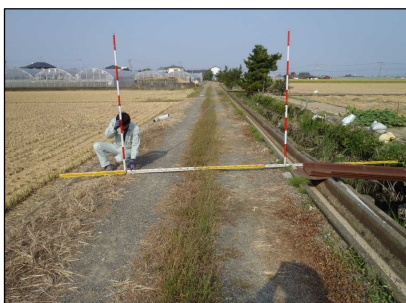
写真① 道路及び水路の状況
