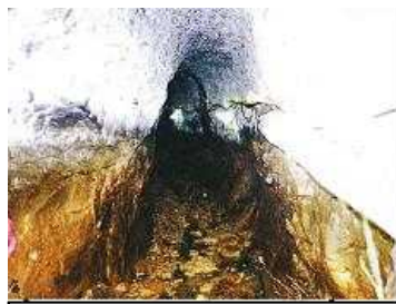
写真② 用水路(隧道内)の状況
