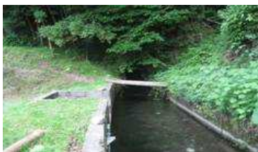
写真① 用水路(隧道入口)の状況
