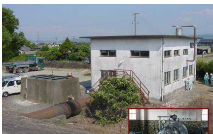
写真① 老朽化した排水機場機場の状況及び水路の状況
