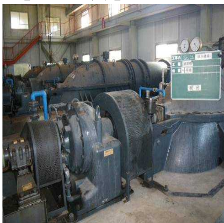
写真① 排水機場内の状況
