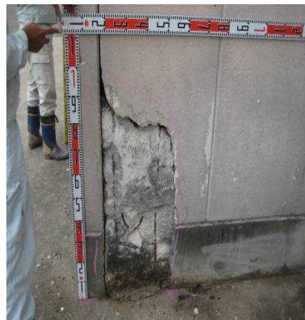
写真② 上屋の状況
