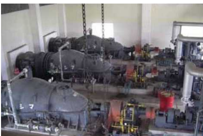
写真① 機場内部の状況
