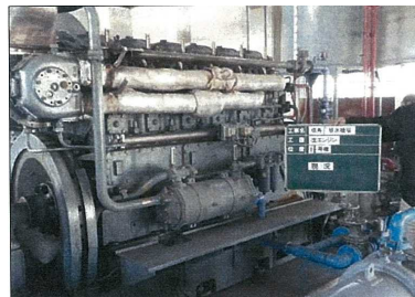
写真② 排水機場施設状況
