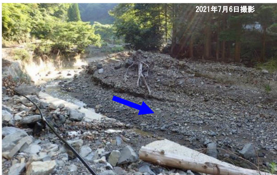
図 万江川河道内の土砂堆積状況
