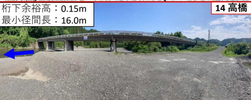
下流の堰の影響で橋梁直下で土砂が堆砂している。
