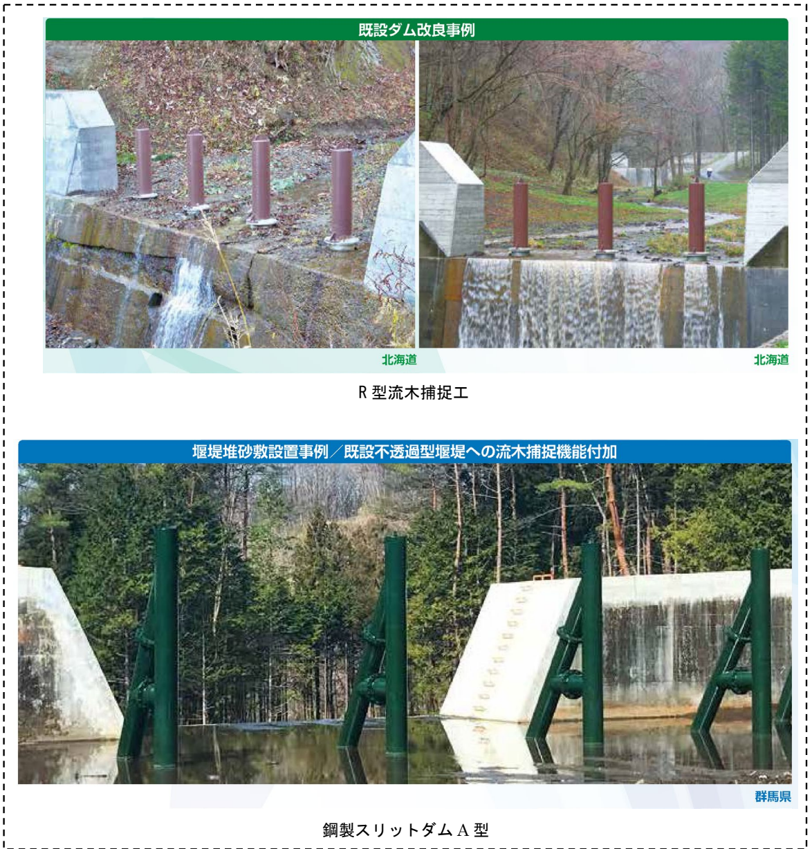
図2 流木捕捉工の事例
