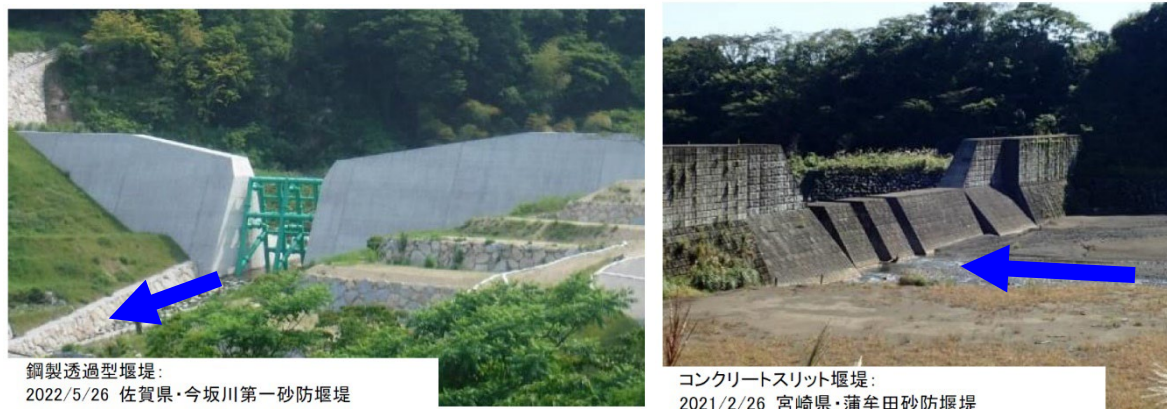
図 透過型砂防堰堤のイメージ
