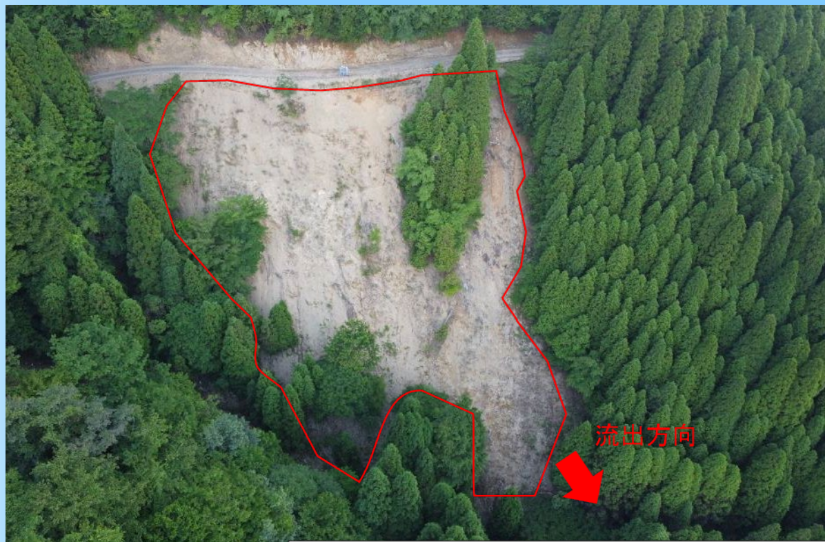
林道より下方の急斜面で山腹崩壊が発生、2021年6月9日撮影
