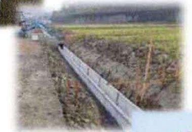
排水路の整備
