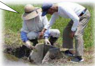
せき板の設置後の管理作業
