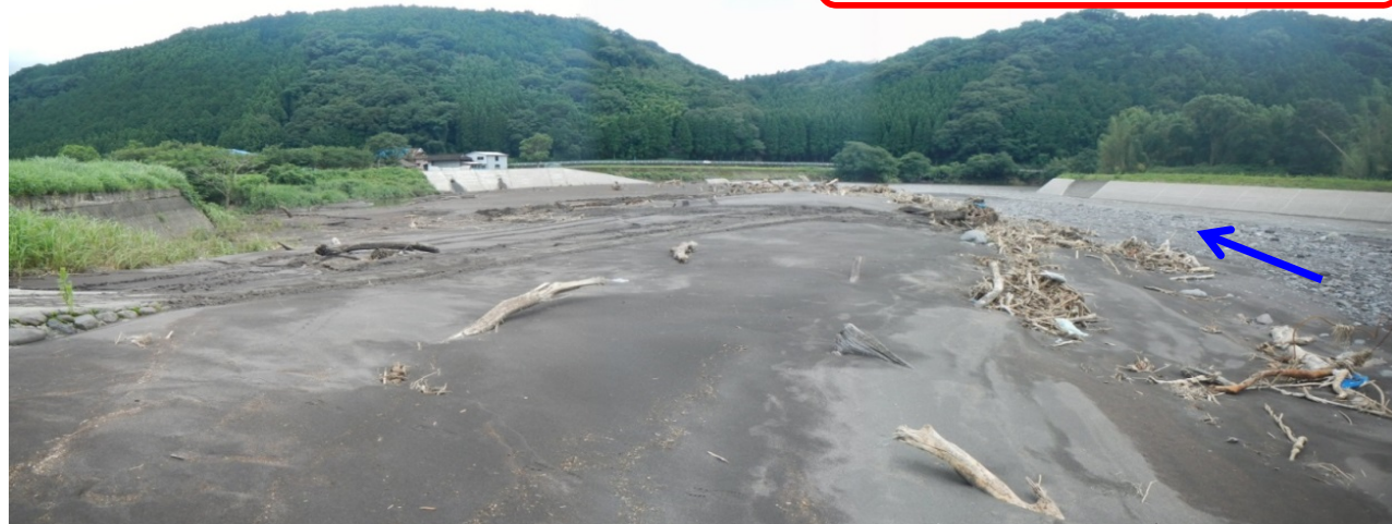
出水後堆積状況
