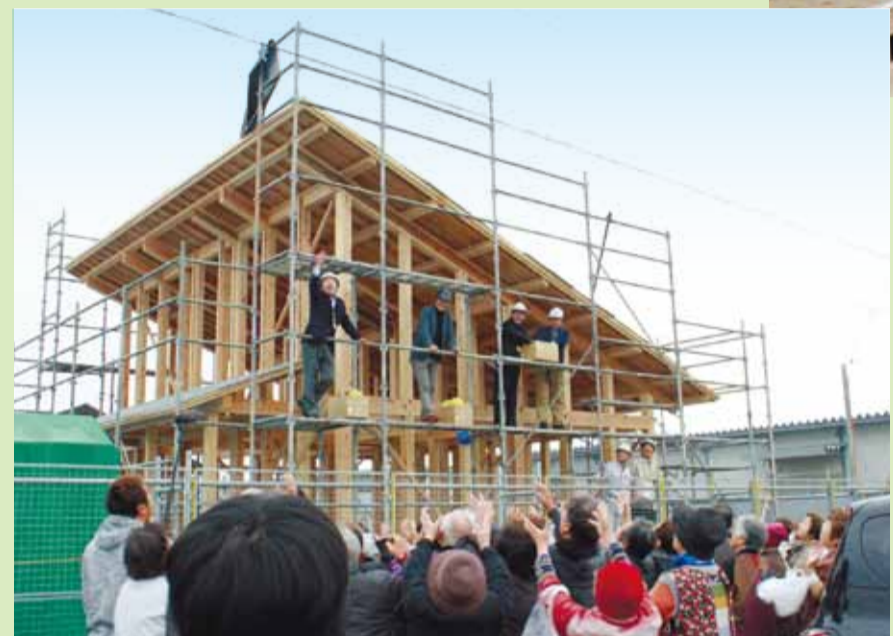
「くまもと型復興住宅」モデル住宅3号棟(益城町テクノ仮設団地)の上棟式(2月20日)
