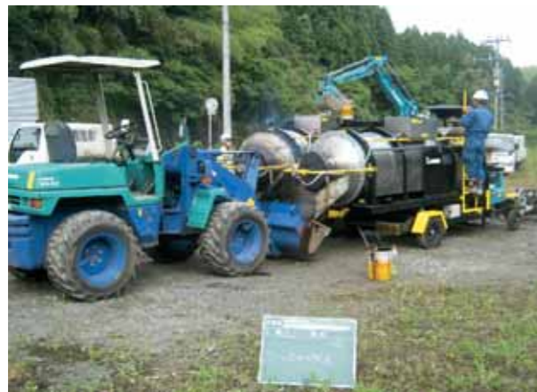
仮設ヤードでの仮設プラント方式状況
