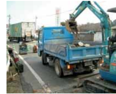
②舗装版積み込み
