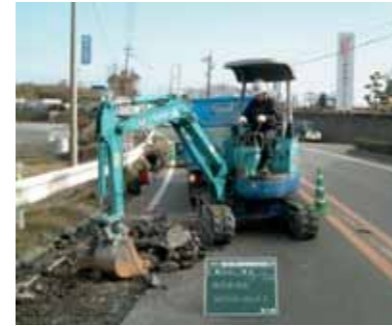
①舗装版剥ぎ取り
