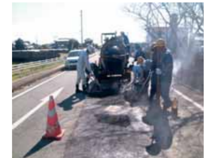
⑥敷き均し・転圧
