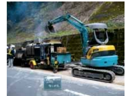
③舗装版投入
