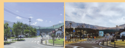
阿蘇くじゅう国立公園における無電柱化（左が実施前、右が実施後）
