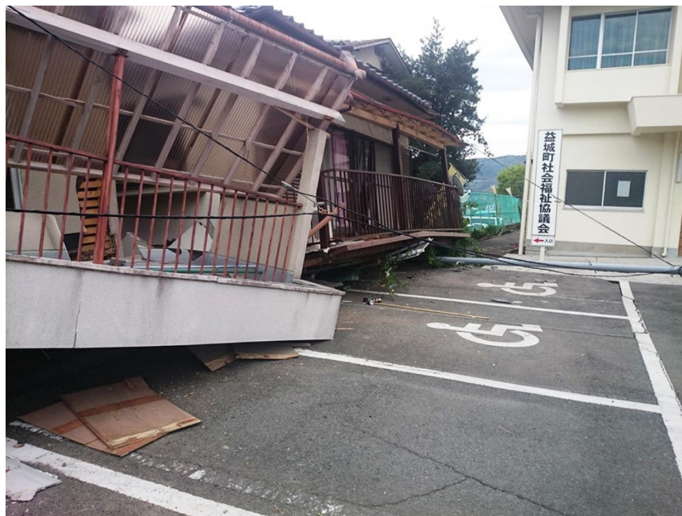
災害ボランティアセンター設置予定だった益城町公民館(右奥)
