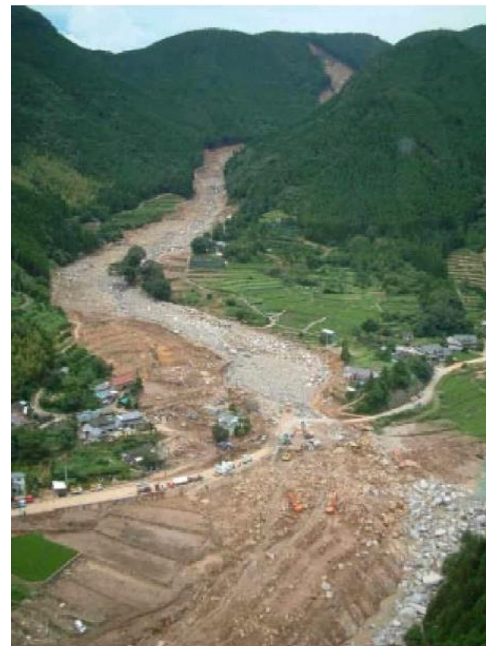
宝川内地区の被害状況（水俣市）
