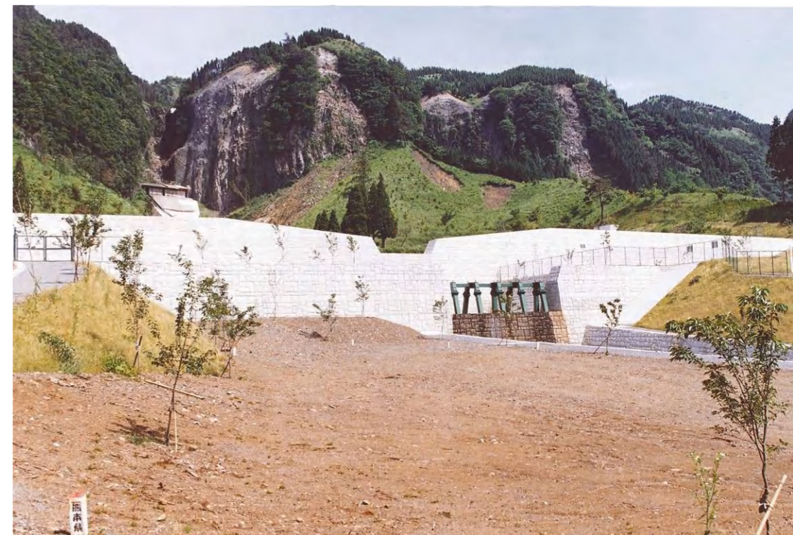
写真 2.3-4 まめふた 豆札川砂防堰堤 完成直後
