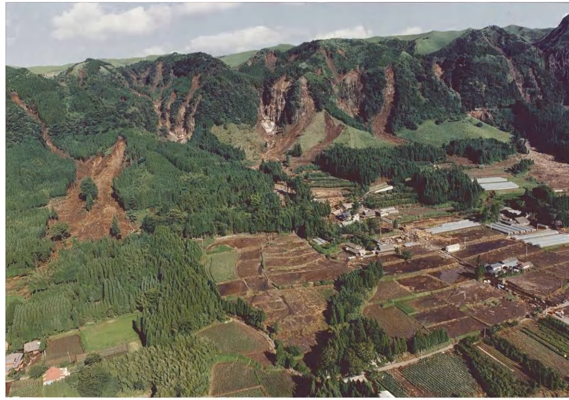
写真 2.3-1 さかなし 坂梨地区崩壊状況
