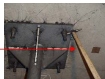
打音検査の例
