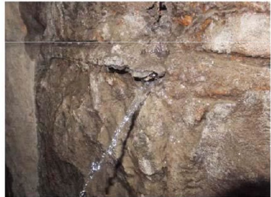
付写真-1.7 漏水（噴出）している例
