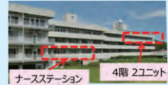
小山田特別養護老人ホーム 概観 出所：https://seizanrikai.jp/facilities/ (最終閲覧日：2020年2月3日)
