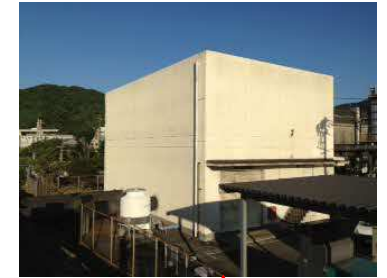
田浦港排水機場
