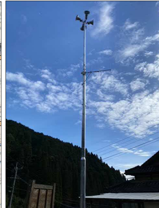
新たに設置した屋外拡声子局 25
