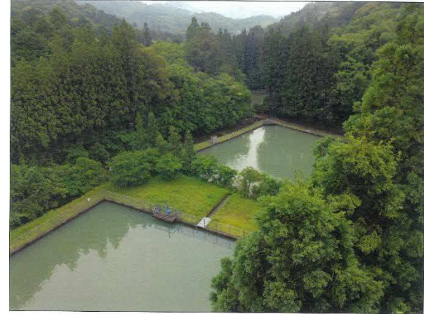
防災重点農業用ため池
