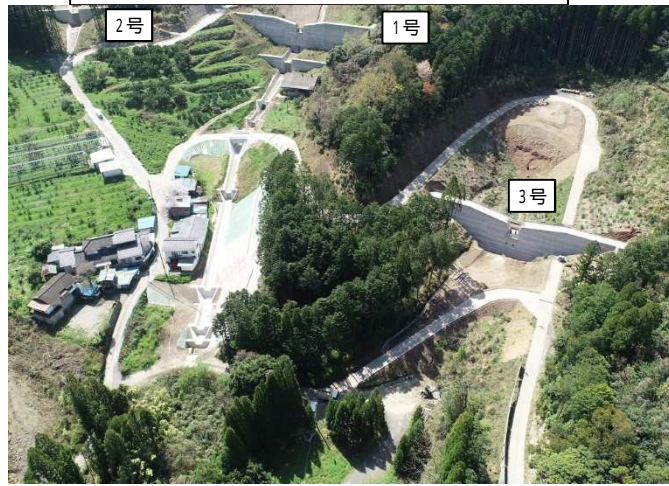
上初野川 1号、2号、3号砂防えん堤 (小津奈木川水系)
