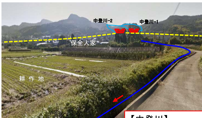
【中登川】 砂防堰堤の整備
