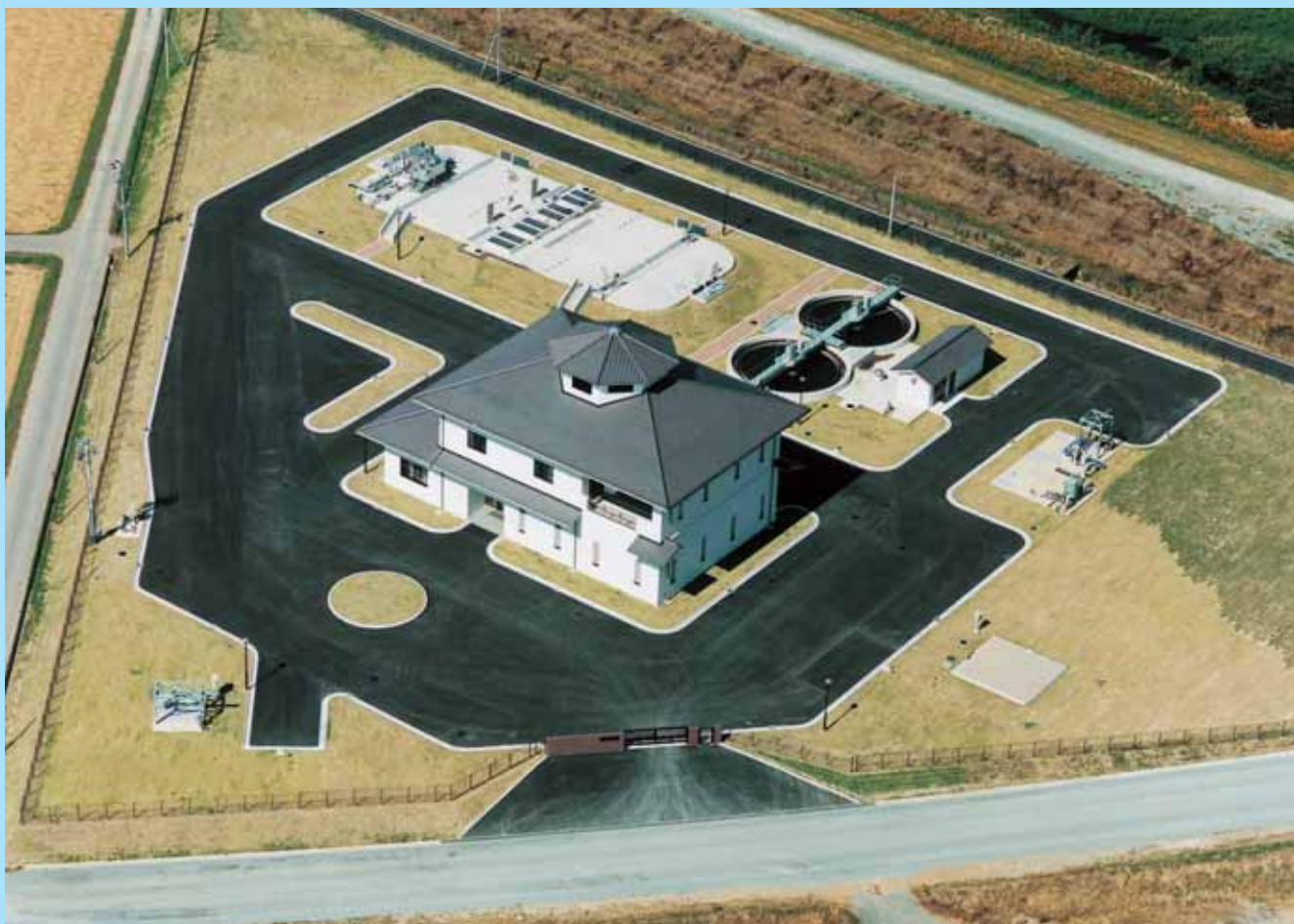
七城中央浄化センター(菊池市)
